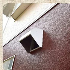
換気扇フードも白で 塗装させていただきました。
