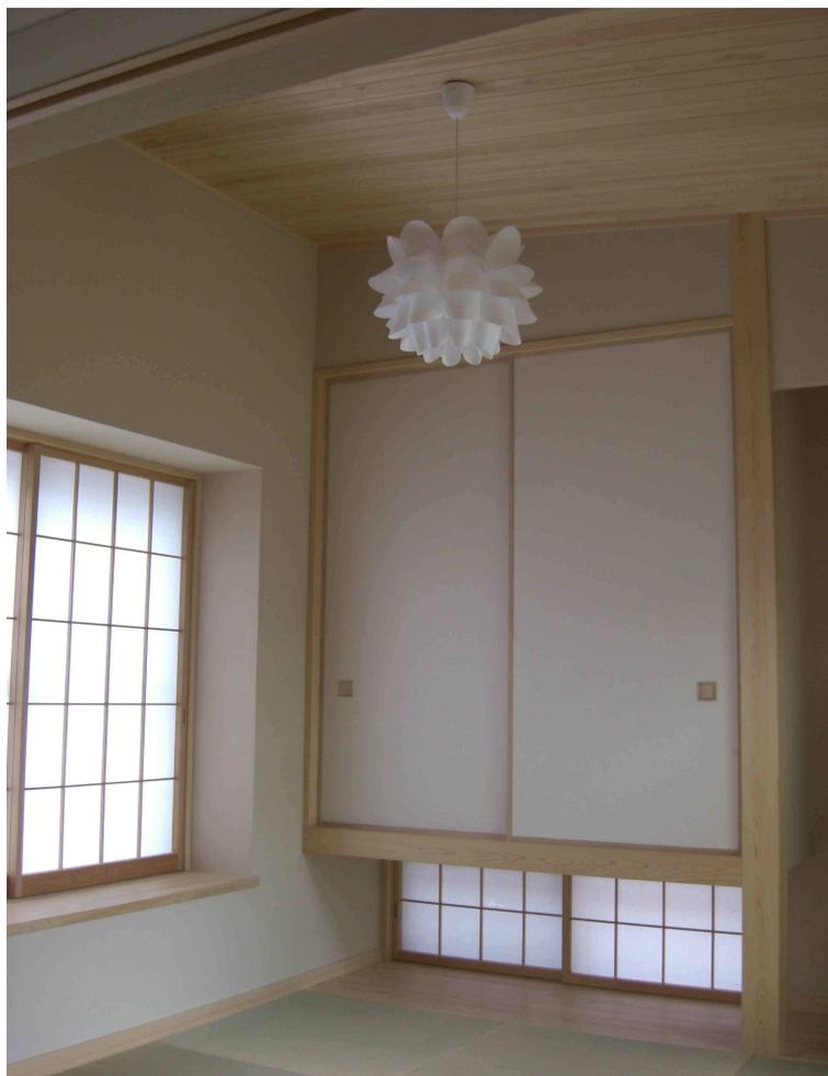
4寸の床柱に天井の羽目板は吉野産の桧です。琉球調の畳に、壁は珪藻土でモダンな和室ができました。
